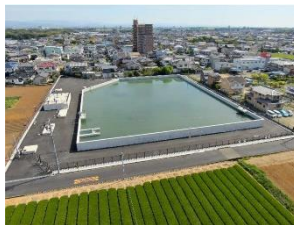
西山調整池 (農業用水施設)
